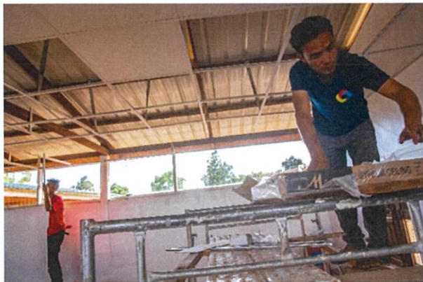
緬甸專案學校照明改善工程-天花板修繕
